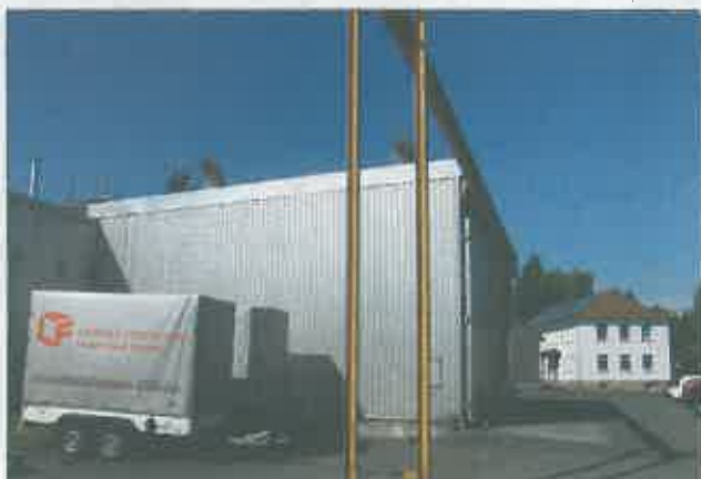
Die Holzheizung versorgt die Trockenkammern, die Produktions- und das Bürogebäude (rechts) mit Wärme.
