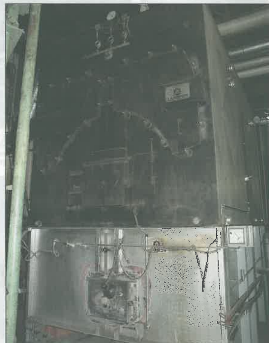
Der Kessel nutzt die in der Produktion anfallenden Späne, um den gesamten Wärmebedarf des Betriebes vollständig zu decken.
